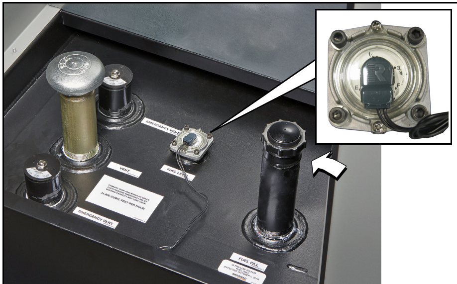
Figure 5-7. Vérification de la jauge de niveau de carburant et remplissage
